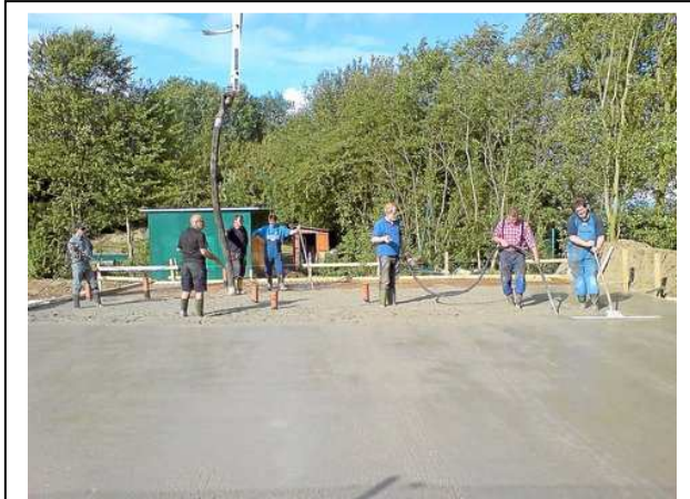
In Eigenleistung haben Mitglieder der Ottmarsbocholter Vereine insgesamt 42 Kubikmeter Beton verarbeitet und die Sohle für das neue Tennisheim und den Luftgewehrschießstand fertiggestellt. Foto: (privat)
